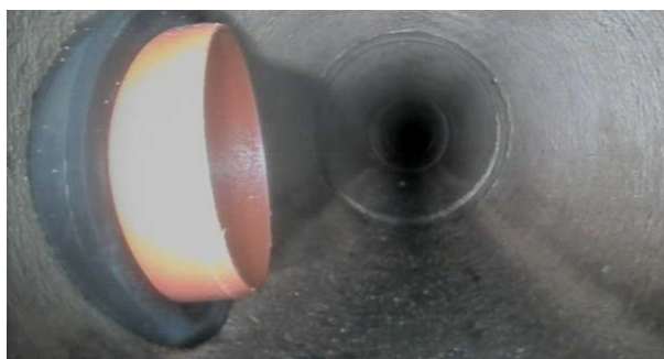
Figur 5. Exempel på för långt instick.
